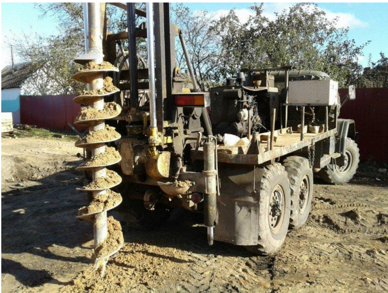
Рисунок 2.2 – Буровая установка ПБУ 2-114
