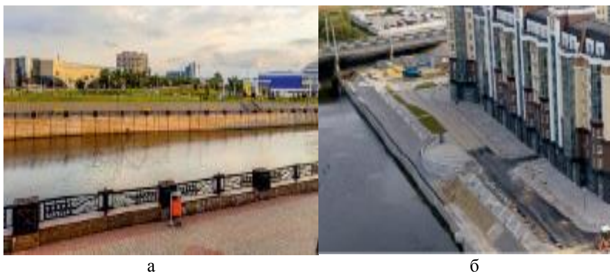
Рис. 3.18. Бетонные набережные реки Везелка: а – у спортивного комплекса С. Хоркиной, б – у жилого комплекса «Париж» [10]
