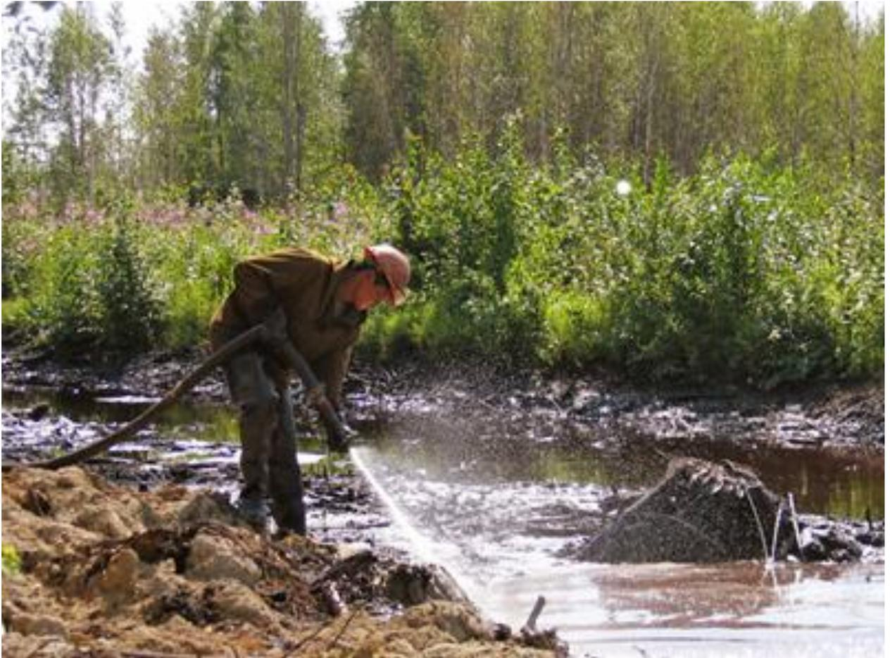
*Рис. 3.5.* Работа подрядных организаций по сбору нефти путем смыва с поверхности почвы (с использованием мотопомп)
