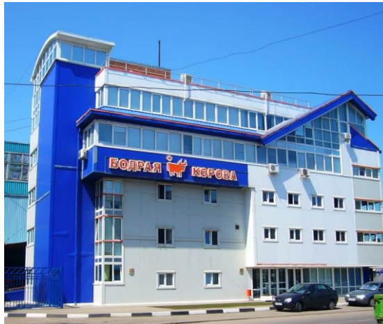
Рис. 2.1. Фасад здания ОАО «Белгородский хладокомбинат»
