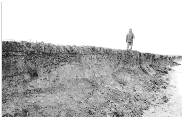
Рис.14. Вид с запада на почвенную траншею в осевой зоне межевого вала 2. Март 2003 г.
